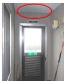
避難扉の外部に設置
