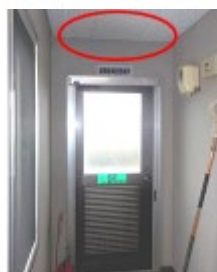
避難扉の外部に設置
