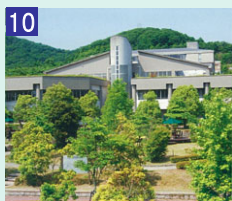
10 大学会館 (M棟)
