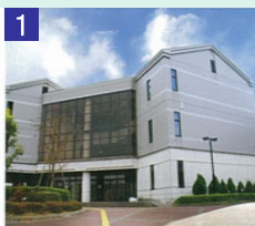
1 共通講義棟 (A棟)
