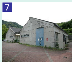
7 工房棟 (G棟)
