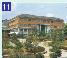
11 事務局棟 (N棟)
