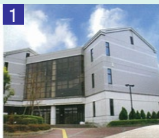
1 共通講義棟 (A棟)
