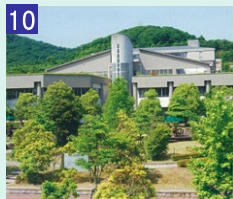
10 大学会館 (M棟)
