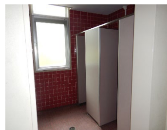
B棟女子トイレ・改修前
