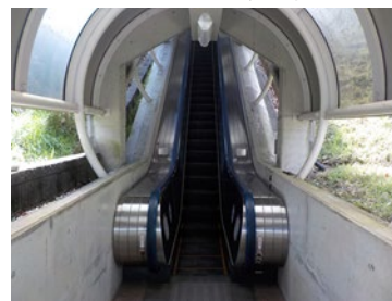
エスカレーター・改修前
