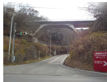
構内道路・橋梁
