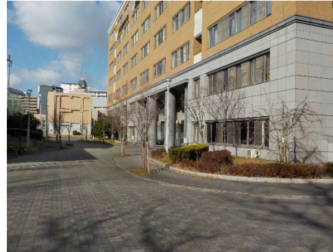
中央館前パブリックスペース
