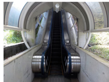
エスカレーター・改修前
