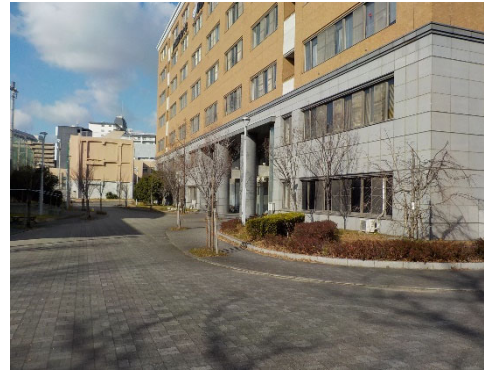
中央館前パブリックスペース
