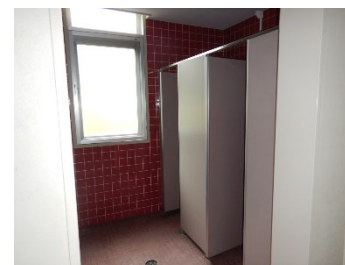
B棟女子トイレ・改修前
