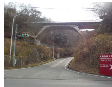
構内道路・橋梁
