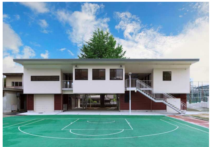
完成したクラブハウス
