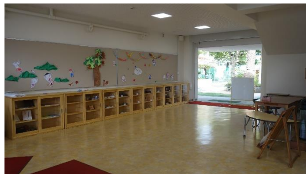
改修工事を行った附属幼稚園(玄関ホール)
