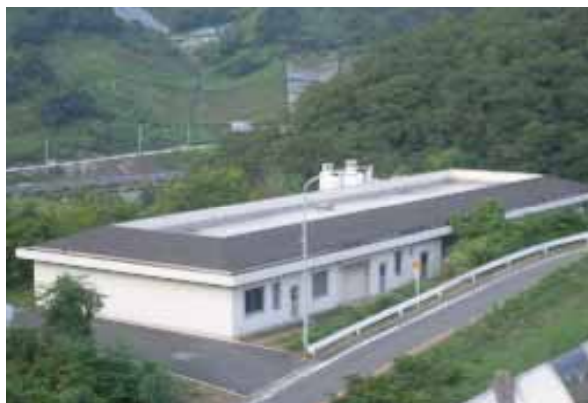
排水処理施設
