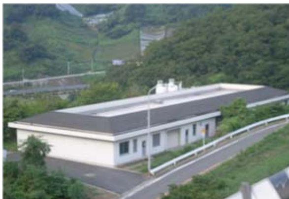
排水処理施設
