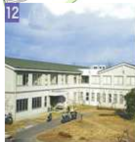
12 課外活動共用施設 H6 RC2F 1, 989㎡ 体育系共用室、文化系共用室、合宿室などがあり、課外活動の拠点になっています。
