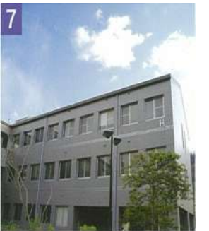
7 体育・スポーツ棟 H3 RC4F 1, 745㎡ 実験実習室、講義室、セミナー室、研究室などがあります。
