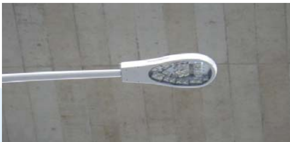
改修後の状況
