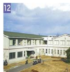
12 課外活動共用施設 H6 RC2F 1,989㎡ 体育系共用室、文化系共用室、合宿室などあり、課外活動の拠点になっています。
