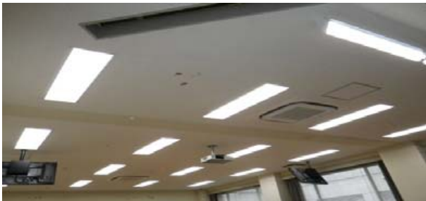
改修後の状況
