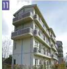
11 留学生宿舎 H6 RC4F 1,004㎡ 40室(寮室定員男性18人、女性22人)あり、 留学生に居住の場を提供しています。
