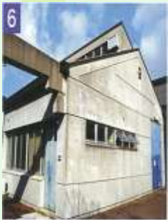
6 工房棟 H3 RC1F 797㎡ 彫刻室、金工室、立体室、木工室、窯工室、 研究室などがあります。
