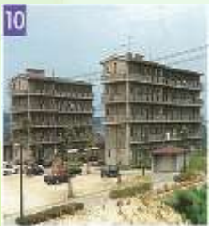
10 学生宿舎 H5 RC5F 2,560㎡ 男子学生宿舎(18寮室定員90名)1棟、 女子学生宿舎(18寮室定員90名)1棟があります。
