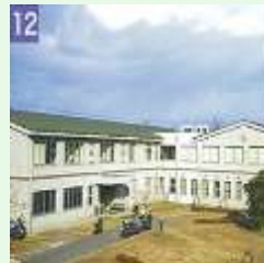
12 課外活動共用施設 H6 RC2F 1,989㎡ 体育系共用室、文化系共用室、合宿室などがあり、 課外活動の拠点になっています。
