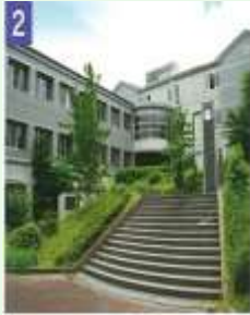
2 教養学科棟 H3 RC4F 12,894㎡ 講義室、実習室、研究室などがあり、 教養学科の講義、研究が行われています。
