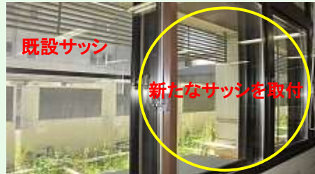
改修後の状況
