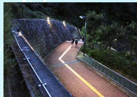
エスカレーター横階段付近
