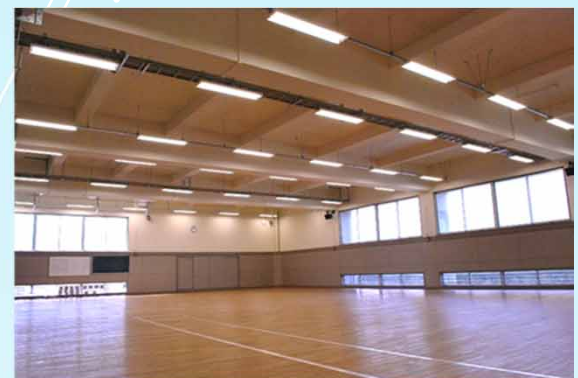
武道場（改修後）
