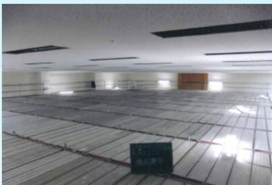
武道場（改修前）
