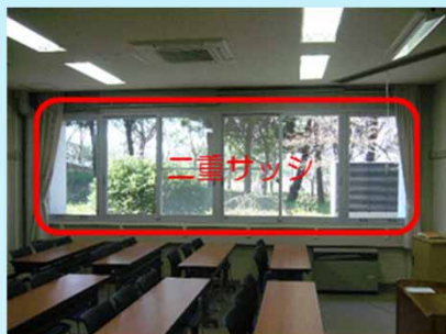
教養学科棟講義室改修後
