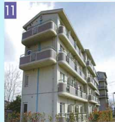
11 留学生宿舎 H6 RC4F 1,004㎡ 40室(収容定員男性18人、女性22人)あり、留学生に居住の場を提供しています。
