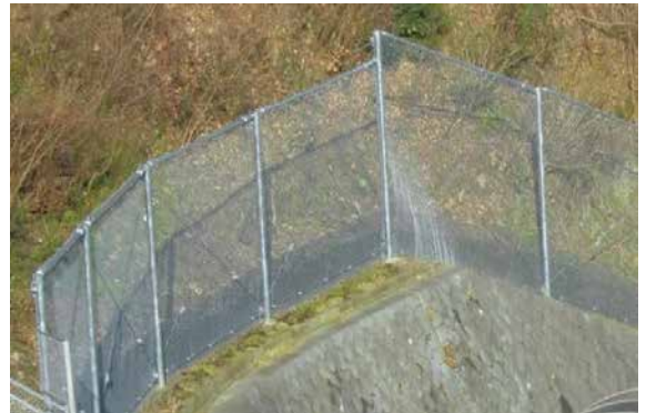
完成後（落石防護柵）
