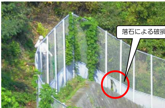
着工前（一般的メッシュフェンス）
