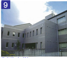
9 音楽棟 (K棟) リハーサルホール、実習室、練習室、講義室、研究室などがあります。
