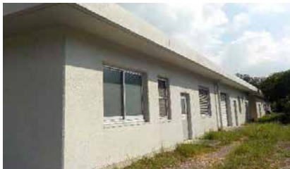
＊ 排水処理施設
