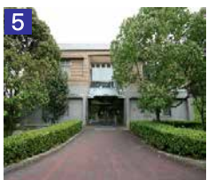
5 情報処理センター (E棟)
