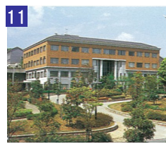
11 事務局棟 (N棟)
