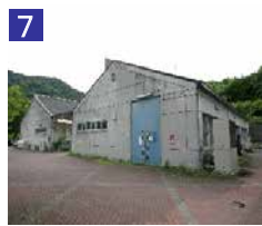
7 工房棟 (G棟)
