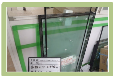
● 複層ガラス設置
