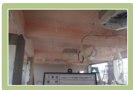
● 屋上スラブ断熱工事
