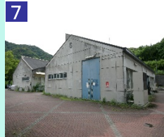
7 工房棟 (G棟) 彫刻室、金工室、立体室、木工室、窯工室、研究室などがあります。
